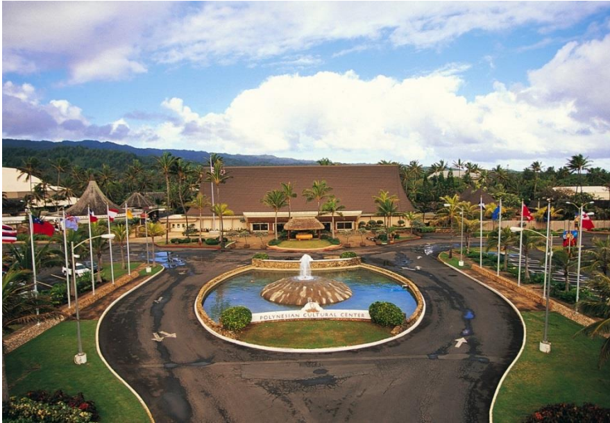
PCC正面入口
